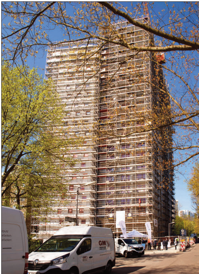
Im neuen Hochhaus der degewo am Friedrich-Kayßler-Weg entstehen 151 Wohnungen, 50 Prozent mietpreisgebunden.
