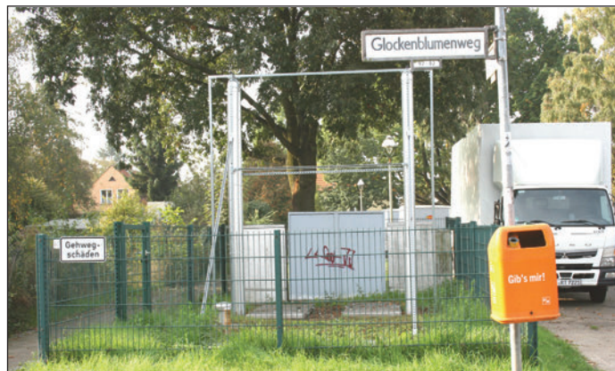
Die Brunnengalerie am Glockenblumenweg Ecke Arnikaweg im Blumenviertel, 1997 in Betrieb genommen, soll nun abgeschaltet werden.
